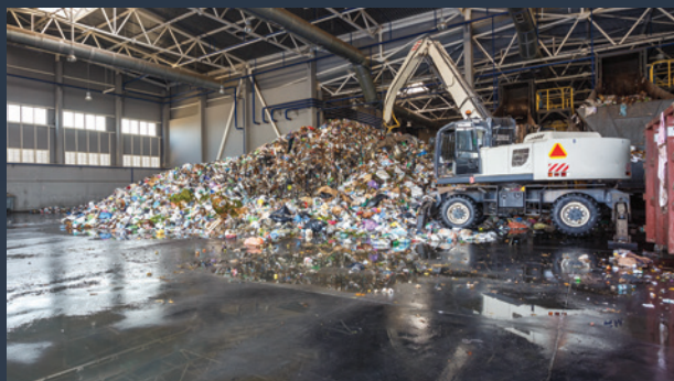
■ RECYKLAČNÍ A ODPADOVÉ HALY
